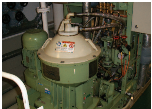
润滑油净化器排出固体和可溶性杂质
