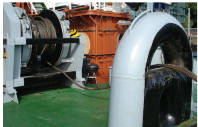
一艘港内拖轮船尾附近的拖缆导向轮，该拖轮配有3个科特导流管内全向推进螺旋桨，前面2个，后面1个。
