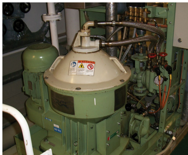
Bộ tinh lọc dầu bôi trơn phân tách các tạp chất rắn hòa tan
